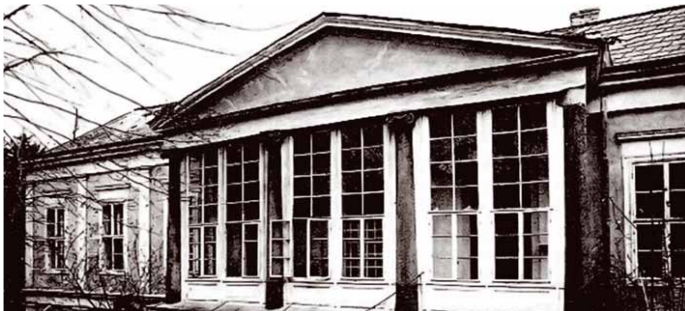
Meierei am Tivoli, Zustand vor dem Abbruch 1991
