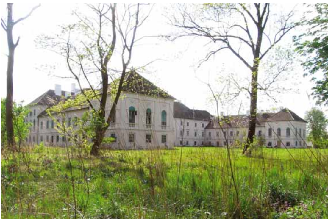
Die Idylle täuscht: Schloss Trautmannsdorf ist im Inneren stark baufällig
