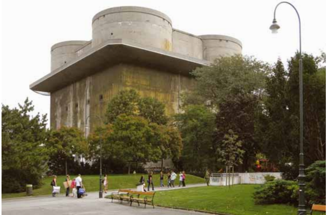
Der Arenbergpark mit Flakturm
