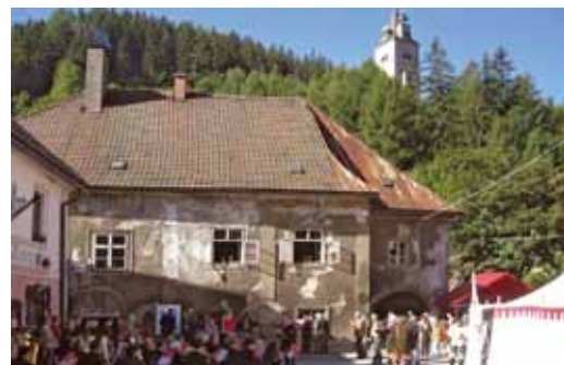
Eisenerz, „Schwarzer Hof“ der Baukulturstiftung
